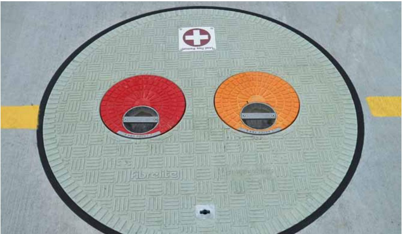
Faserverbund-Schachtabdeckung mit 2 integrierten Innendeckeln
