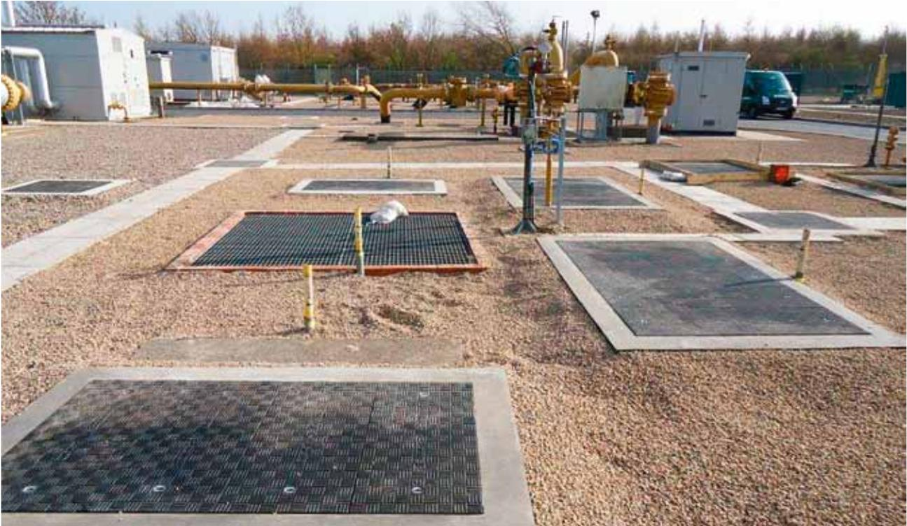
Faserverbund-Reihenabdeckung im Betriebsgelände extrem leicht für schnelle Zugriffe
