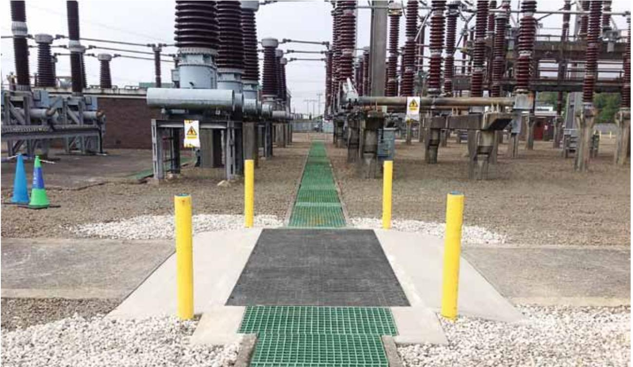
Faserverbund-Reihenabdeckungen im Einsatz bei einem Stromerzeuger
