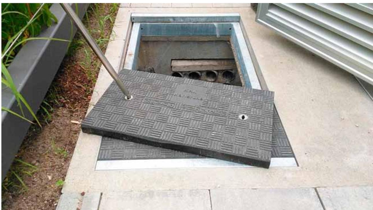
Faserverbundabdeckungen für Trafostation mit Unterkonstruktion, die den Höhenunterschied zwischen den Faserverbundabdeckungen und den ursprünglich vorhandenen Deckeln ausgleicht.
