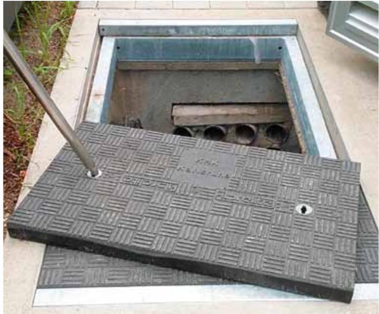
Die ursprünglich installierten 17 cm starken Deckel aus Stahl mit Betonfüllung wurden durch Faserverbundabdeckungen und einer Unterkonstruktion, die den Höhenunterschied zwischen den Faserverbundabdeckungen und den ursprünglich vorhandenen Deckeln ausgleicht, ersetzt.
