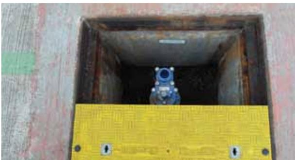
Früher mussten zwei extrem schwere Stahlabdeckungen entfernt werden, um an den Hydranten für die Trinkwasserversorgung zu gelangen. Dank der Faserverbundabdeckung gehört das der Vergangenheit an.
