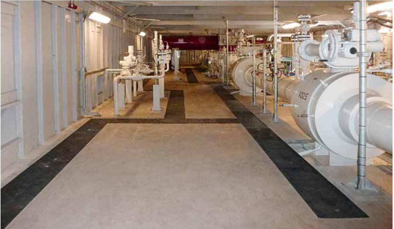
Faserverbund-Kabelkanalabdeckung im Industriebereich
