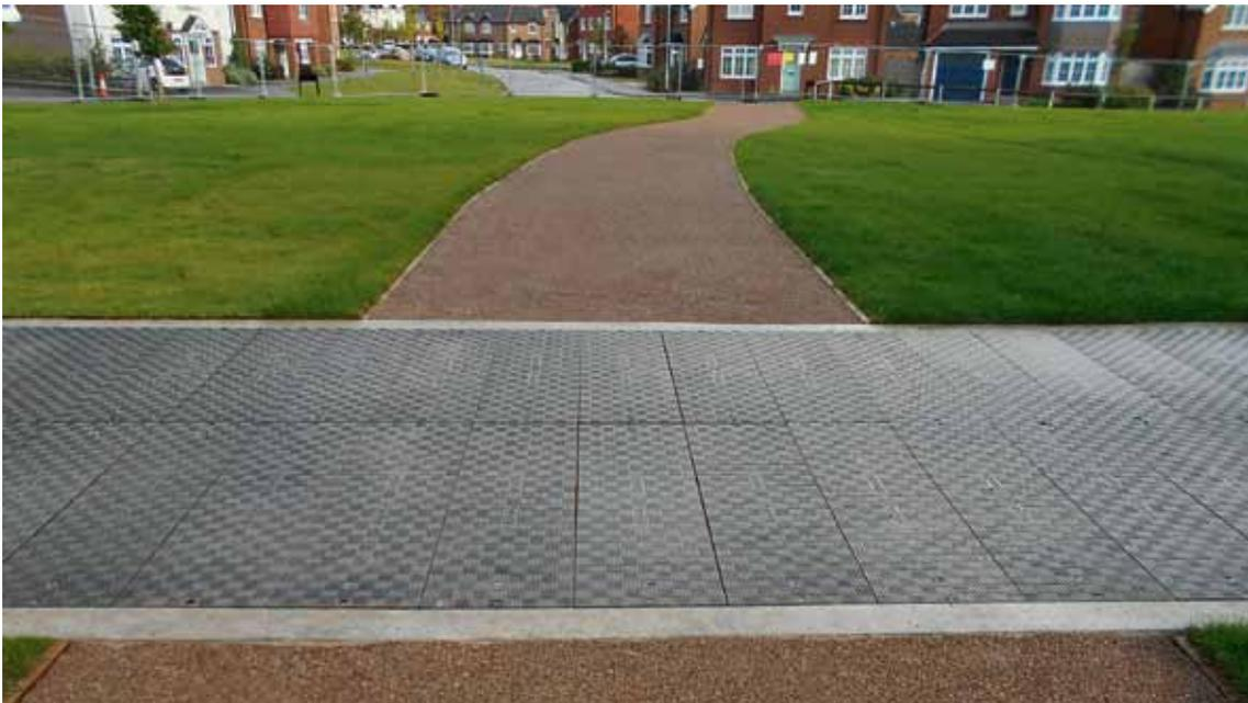
In den Faserverbundabdeckungen sind werkseitig spezielle rutschhemmende Materialien eingearbeitet
