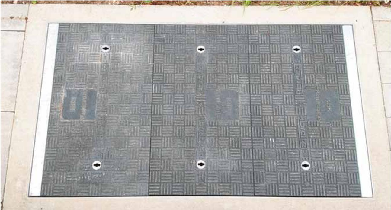
Die Stahlbetonabdeckungen wurden durch leichte Faserverbundabdeckungen ersetzt.
