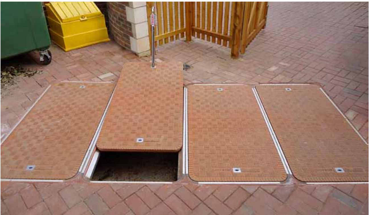
Faserverbund-Schachtabdeckung braun, passend zum Pflaster
