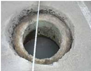
Heraustrennen der Beton-Guss-Schachtabdeckung. Sichtbar ist der darunter liegende Ausgleichsring, welcher bereits gebrochen ist.
