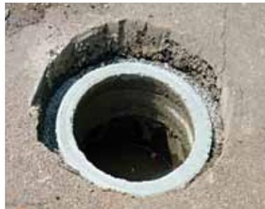
Der schadhafte Beton-Ausgleichsring wurde ebenso heraus getrennt und bereits gegen einen neuen ersetzt.
