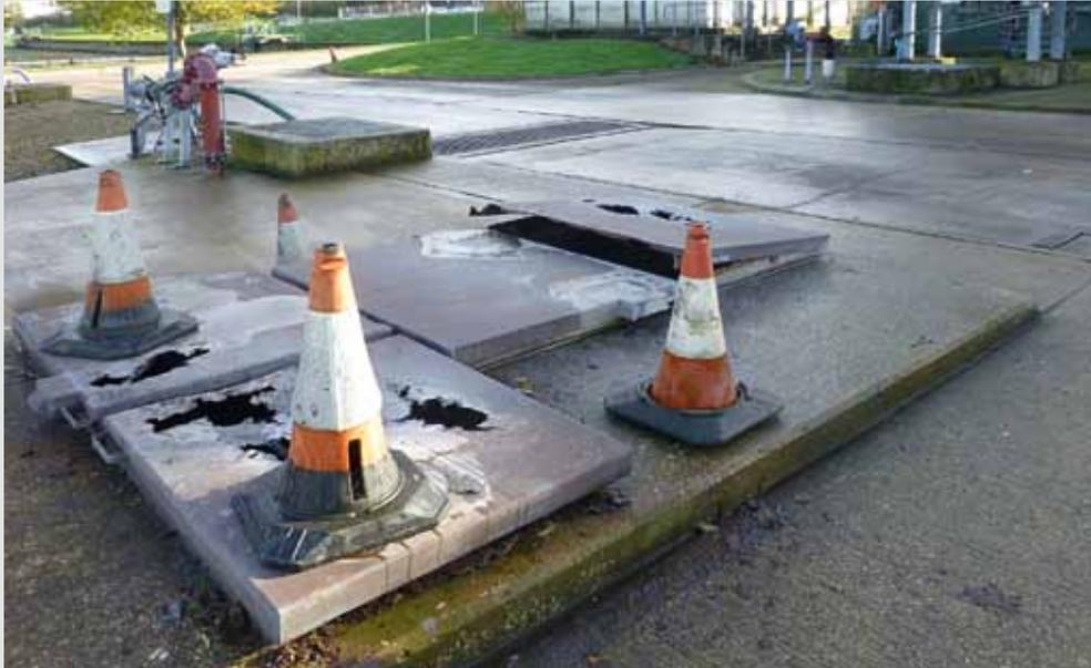
Die ursprünglich installierten, stark beschädigten und korrodierten Stahlabdeckungen
