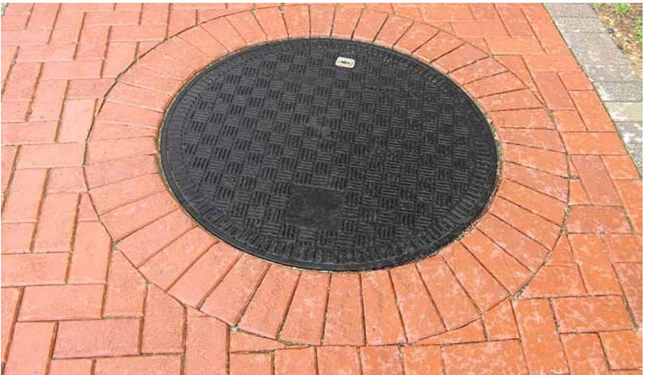
Faserverbund-Schachtabdeckung im eingebauten Pflaster
