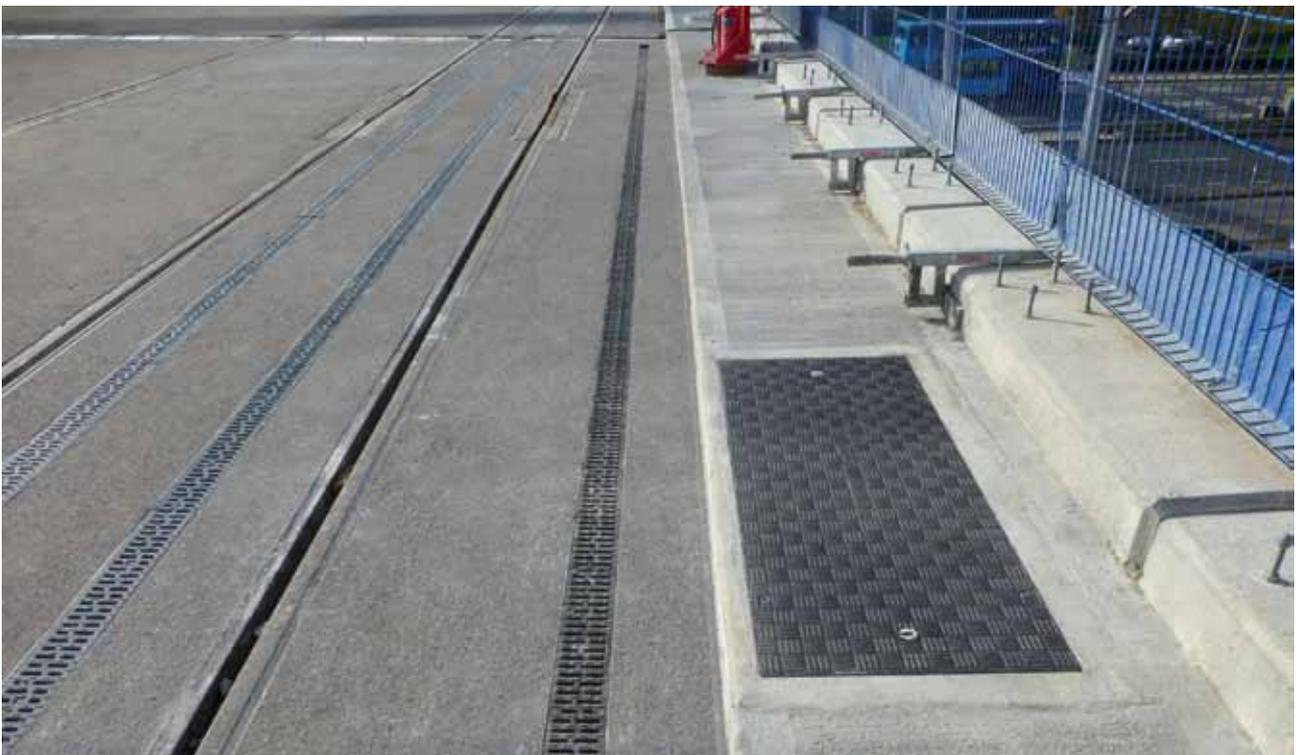
Faserverbund-Schachtabdeckungen an einer S-Bahn-Linie
