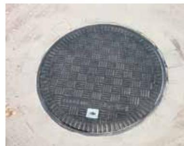
Fertig eingebaute Faserverbund-Abdeckung. Das Epoxidharz-System lässt sich unter Last bis zu 50 % komprimieren und geht dann in seine ursprüngliche Form zurück, auch im Langzeitbetrieb.
