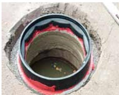
Ausnivellierter, verklebter Rahmen vor dem Verfüllen.
